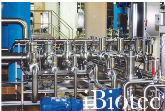
Pulizia di coperture di condotti di distribuzione nell'industria agroalimentare
